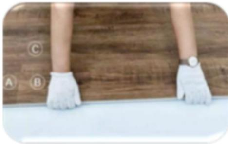
Empuje la superficie de la B hacia la C hasta que se bloqueen.
