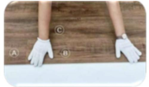
Una vez que se completa el ensamblaje, el piso quedará plano y sin “costuras” en la unión. Si el piso es irregular o tiene espacios, debe levantarlos suavemente. El ángulo está bloqueado y el piso se nivelará automáticamente después de sujetarlo.
