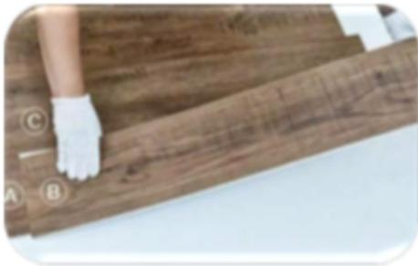
Inserte el tablón B de forma convexa en la ranura existente y asegúrelo plano.
